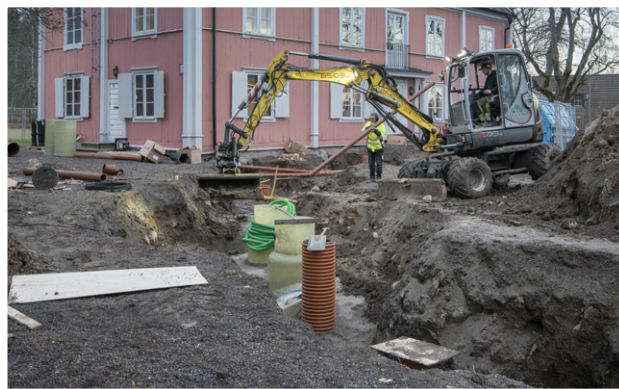
Under stora delar av våren 2020 var gårdsplanen uppgrävd för olika tekniska installationer.
