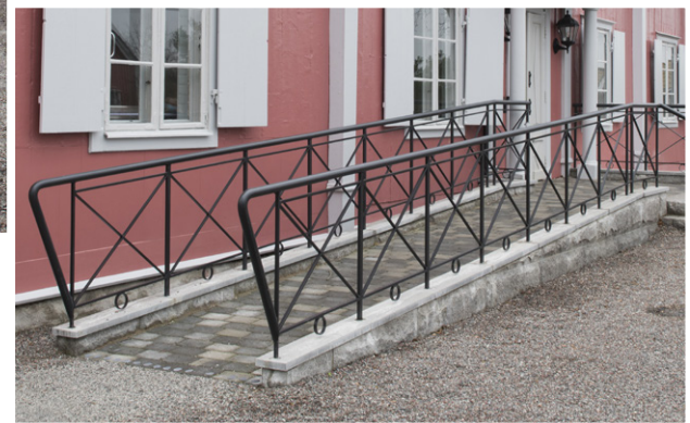
Den nya rampen till entrén underlättar för rörelsehindrade att komma in i huset.
