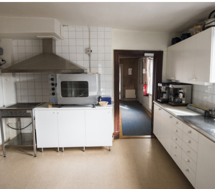
Köket innan renoveringen. Svårarbetat och slitet.
