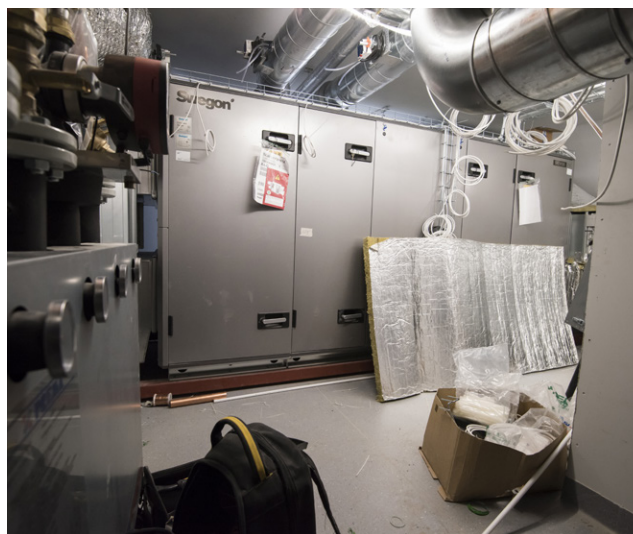
Den södra delen av vinden, där föreningen tidigare hade sitt kontor. Skåpen med styrutrustning till klimatsystemet fick bäras upp i delar och monteras på plats.
