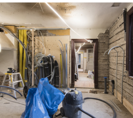
De liggande stockarna i ytterväggarna kom i dagen när 70-talets köksinredning byttes ut.
