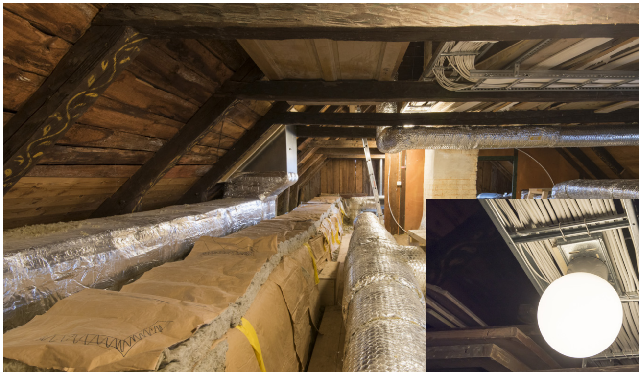
På vinden huserar numera en avancerad klimatanläggning. Notera utsmyckningarna på takstolarna, som har bevarats.
