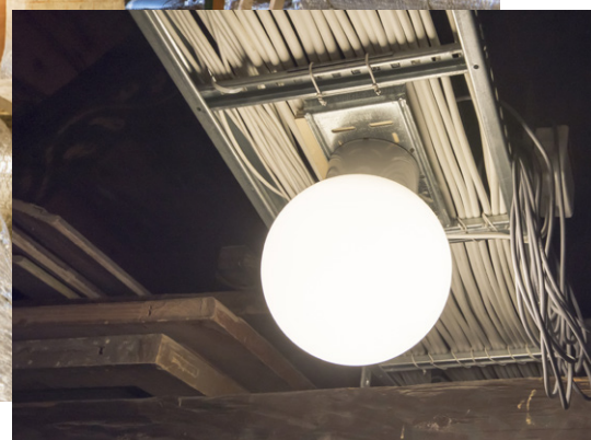
Det har dragits många meter kabel.
