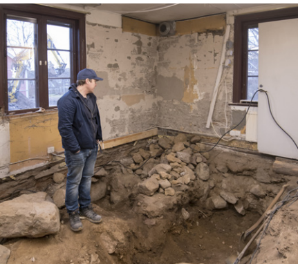
Golvet i köket vilade direkt på marken, som fick grävas ur för att ge plats åt avlopp och andra ledningar.
