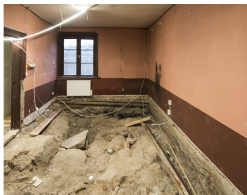
Det lilla rummet innanför köket är avsett för disk och servering. Även här var golvet och de nedre stockarna i så dåligt skick att man måste riva upp golvet.
