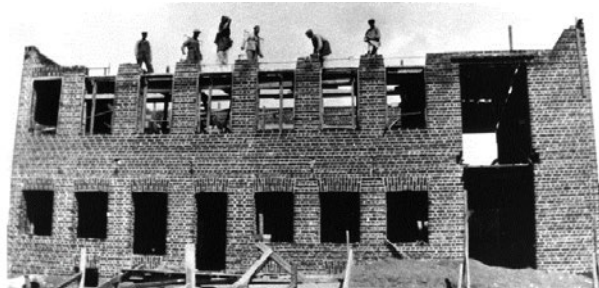
Folkets Hus under byggnad 1933–34, uppfört med gedigen ideell handkraft.
